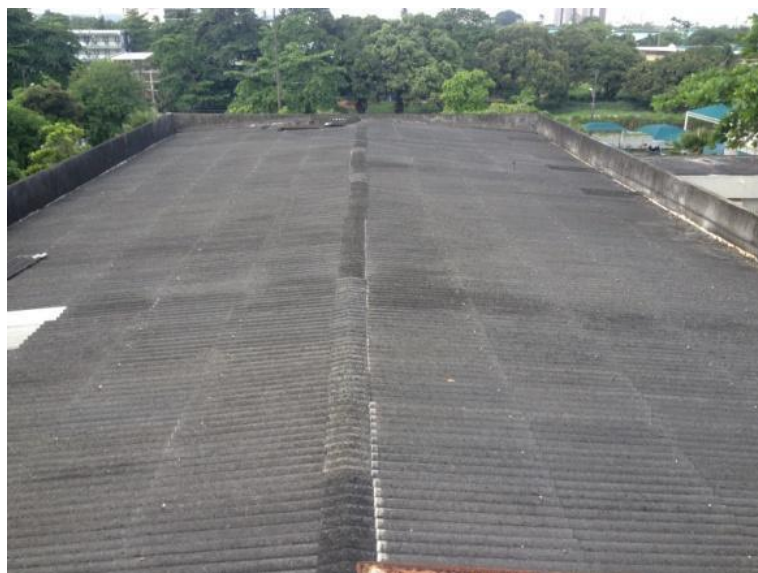
Figura 2. Cobertura do bloco F do IFPE.
