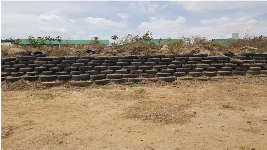
**Figura 4** – Muro de Arrimo Concluído
