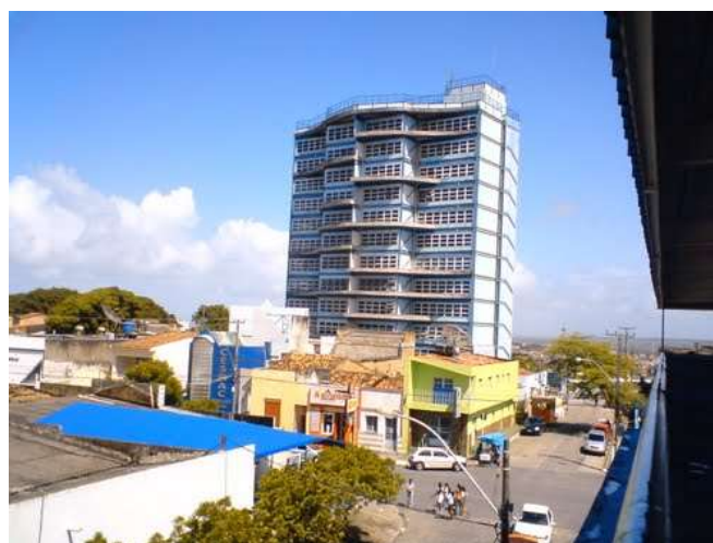
Figura 1. Campus da instituição de ensino superior em Maceió, AL.
